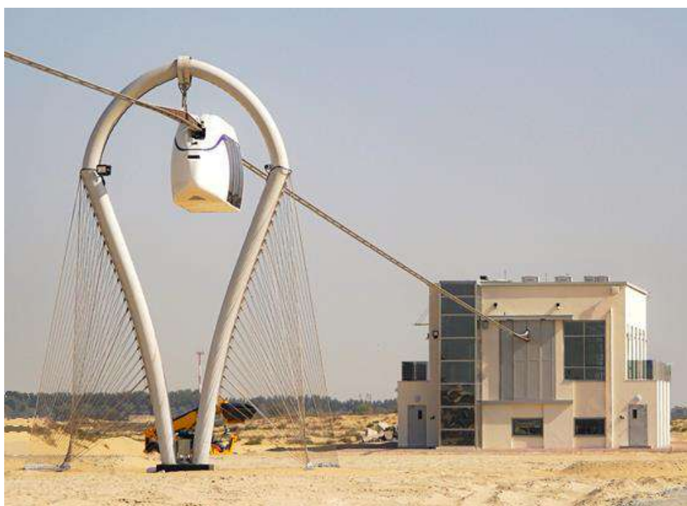
Рис. 20. Гибкая рельсо-струнная путевая структура в Центре uSky Transport в Шардже
